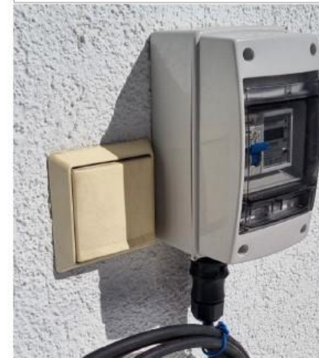
Anschlussbeispiel mit Wieland Stecker und Smart Meter
