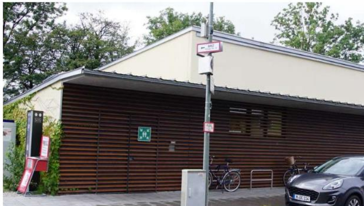
Strom vom Dach: Unter anderem auf der Kinderkrippe St. Christophorus in der Poinger Straße soll 2023 eine PV-Anlage installiert werden. © Bert Brosch
